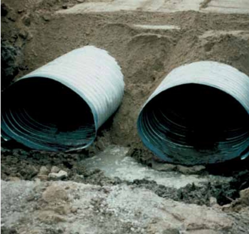
ULTRA-FLO también está disponible en tubos en forma abovedada para aplicaciones de altura limitada.
