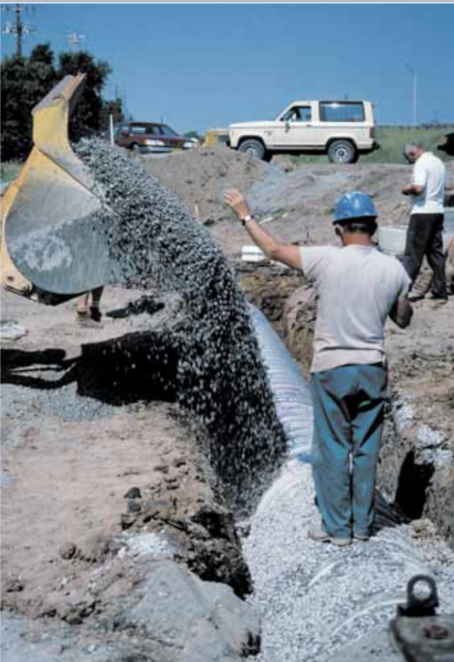
La calidad de los materiales de relleno y la correcta compactación permitirán que la tubería ULTRA-FLO alcance su máxima capacidad de resistencia estructural.
