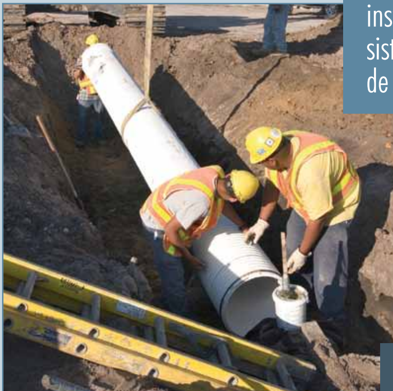
El diseño único de la junta de la tubería A-2000 facilita su montaje en campo. Los diámetros de 4" a 18" se pueden unir manualmente sin necesidad de utilizar equipo mecánico.
