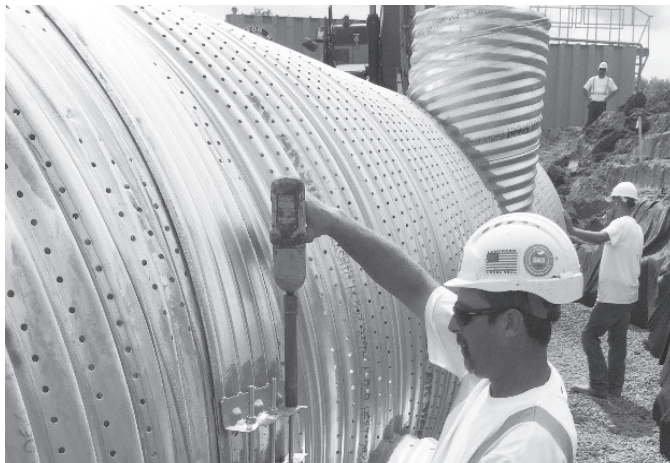
Ajuste de los pernos en una banda corrugada.
