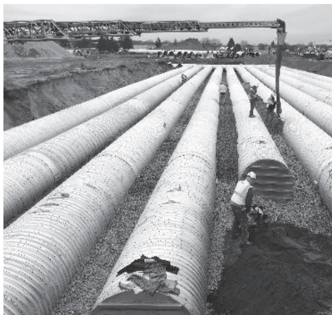
Colocar el relleno con una cinta transportadora.
