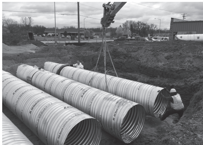
Levantamiento del ALT2 CMP con eslingas de nailon.
