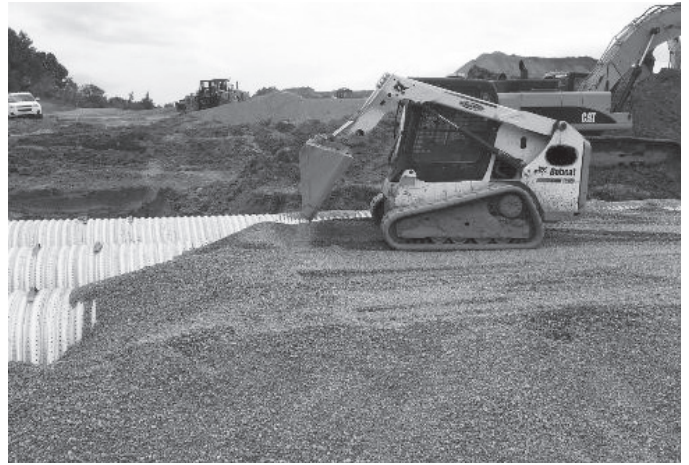
Ejemplos de equipos de construcción ligeros y con orugas utilizados para colocar la cubierta final sobre el sistema de tuberías.
