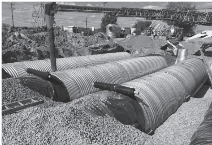
Se extiende un revestimiento de HDPE sobre la corona del tubo antes de poner relleno alrededor del tubo.
