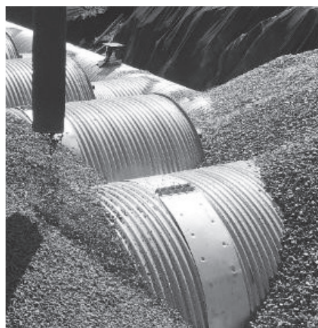
Algunos trabajos pueden requerir bandas especiales, como conexión de varilla y lengüeta, bandas planas o bandas de abolladuras.
