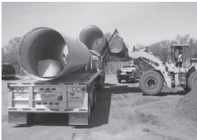
Levantamiento del CMP de la plataforma con una cargadora frontal y horquillas.
