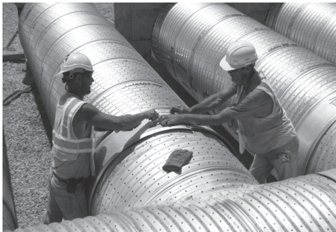
Instalación de una banda envolvente en una tubería perforada.
