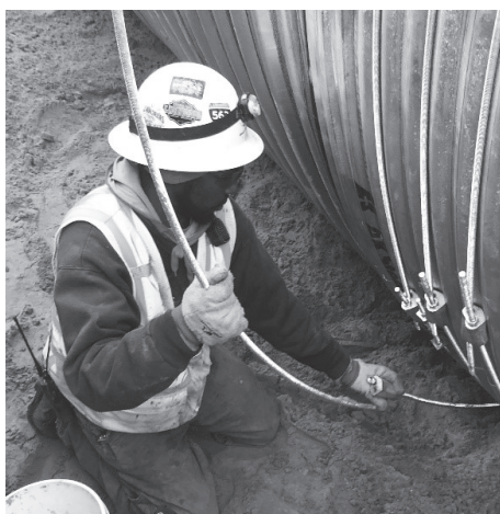
Algunos trabajos pueden requerir bandas especiales, como conexión de varilla y lengüeta, bandas planas o bandas de abolladuras.
