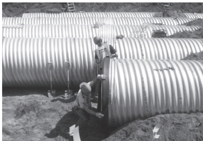
Instalación de la banda con junta plana de neopreno.
