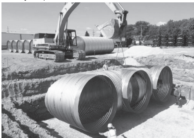
Baje primero la sección del tubo del cabezal a su lugar.
