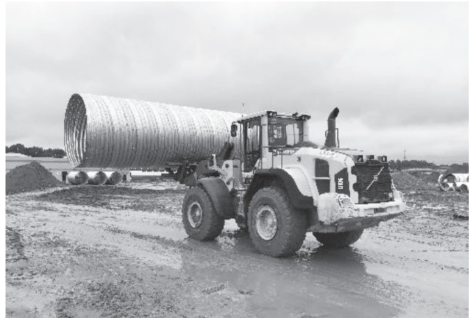
Ejemplos de equipos de construcción pesados que pueden requerir una cobertura mínima adicional. Contech puede ayudar a evaluar la cobertura mínima para el contratista de instalación para todos los equipos en el sitio.
