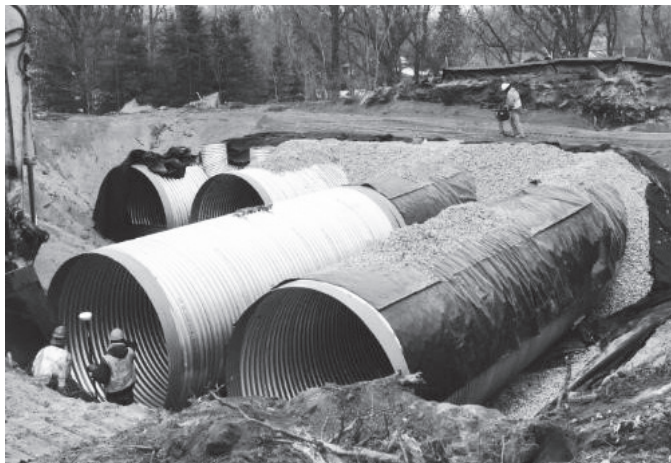
Se extiende un revestimiento de HDPE sobre la corona del tubo antes de poner relleno alrededor del tubo.
