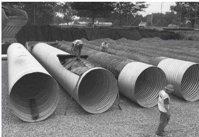
Para tuberías de diámetro grande, el revestimiento se envía en rollos que se doblan por la mitad. El revestimiento se enrolla sobre la corona del tubo, se desdobra y se cubre sobre el tubo desde la posición de las nueve y tres en punto.
