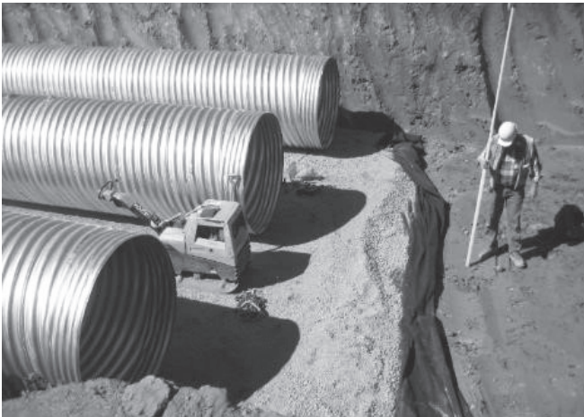
Las condiciones del sitio pueden requerir de 4" a 6" de material granular importado como cimiento para la tubería.
