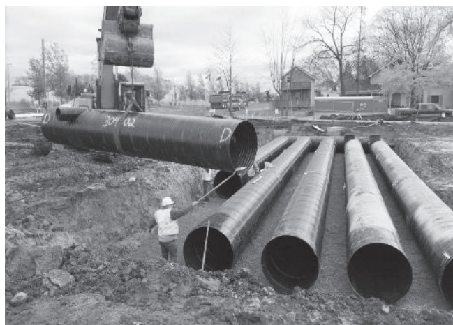
Levantamiento de la plataforma CMP recubierta de polímero y colocación en su lugar con eslingas de nailon.
