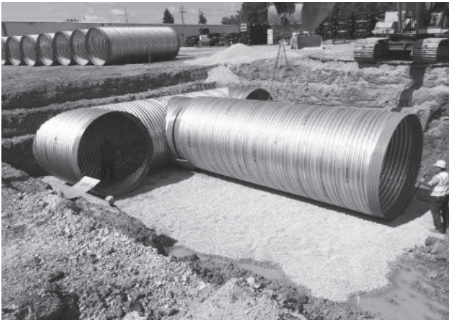
Las condiciones del sitio pueden requerir de 4" a 6" de material granular importado como cimiento para la tubería.
