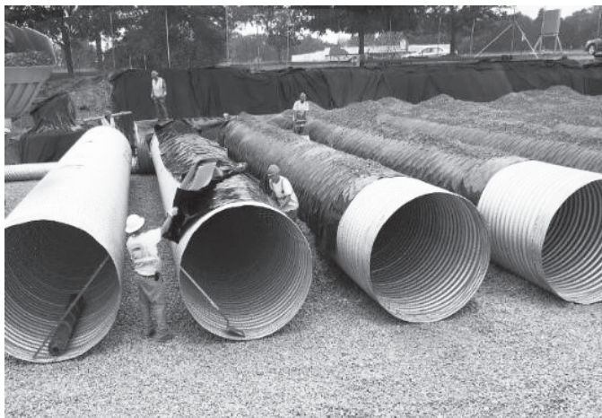
Para tuberías de diámetro grande, el revestimiento se envía en rollos que se doblan por la mitad. El revestimiento se enrolla sobre la corona del tubo, se desdobra y se cubre sobre el tubo desde la posición de las nueve y tres en punto.
