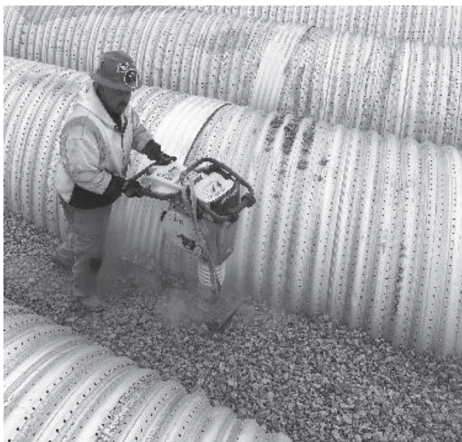
Compactación con equipo vibratorio.
