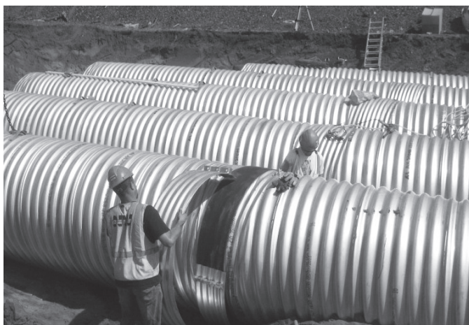
Ajuste de los pernos en una banda corrugada.
