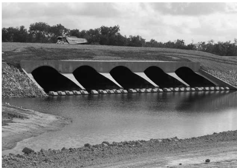
Figura 13. Instalación de Múltiples Barriles con Tratamiento de Bisel Escalonado.
