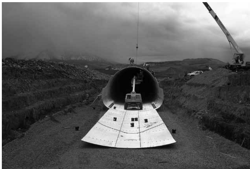
Figura 12 Métodos de levantamiento modernos son utilizados en el ensamblaje de la placa estructural.
